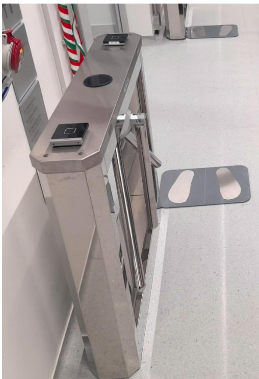
ProxerGate3E forgóvilla beépített ESD vizsgálóval, csuklópánt / cipő teszterrel
